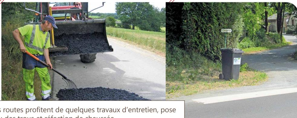
Pendant la période printanière, les routes profitent de quelques travaux d'entretien, pose de point à temps (PATA) au niveau des trous et réfection de chaussée.
