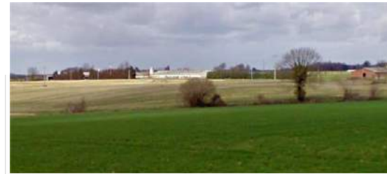
Les structures agricoles ponctuent les paysages et renforcent l'identité agricole du territoire.
